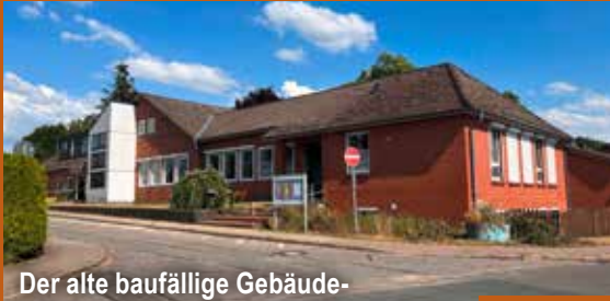
Der alte baufällige Gebäudeteil des Gemeindesaals
